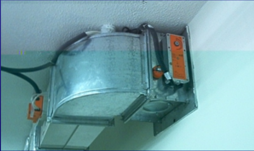
Hava Kanalları Geçişlerinin Yalıtım (Yangın Damperleri)
